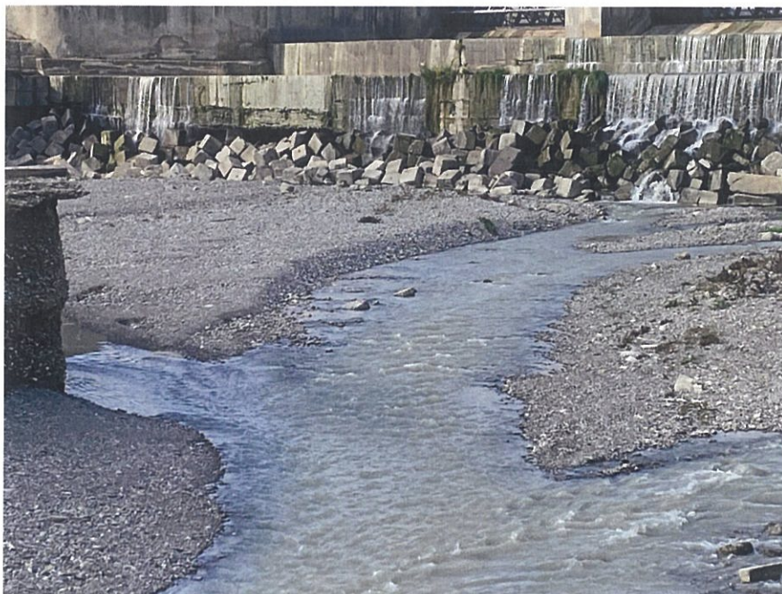
Caverne formate sub grinda de încastrare aval
