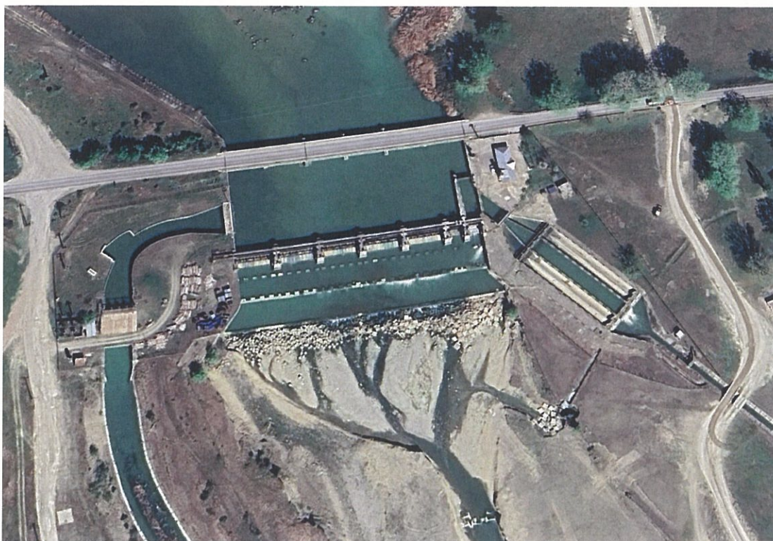
Ansamblul lucrărilor din cadrul amenajării hidrotehnice Nedelea
