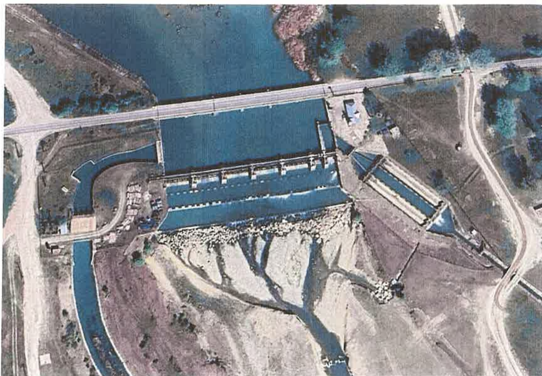
Ansamblul lucrărilor din cadrul amenajării hidrotehnice Nedelea
