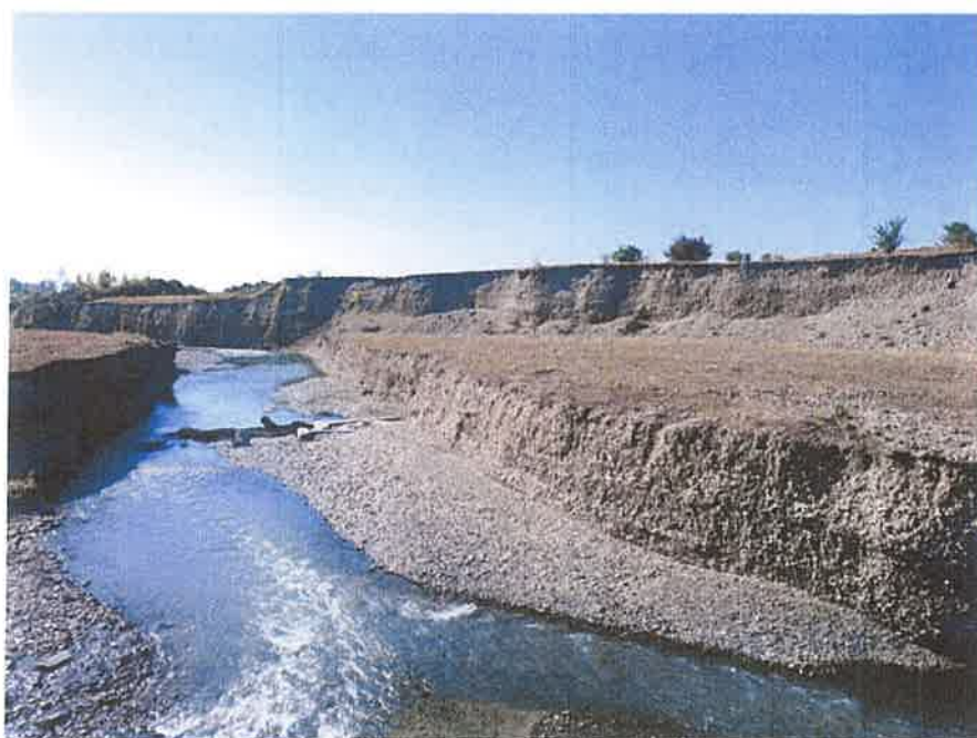
Albia râului Prahova aval de baraj și eroziuni active de maluri
