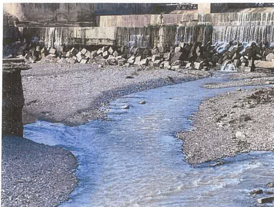
Caverne formate sub grinda de încastrare aval
