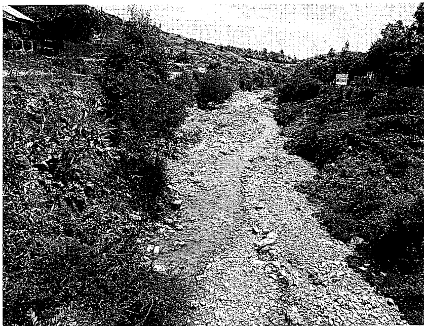
Vedere generală a cursului de apă înspre aval
