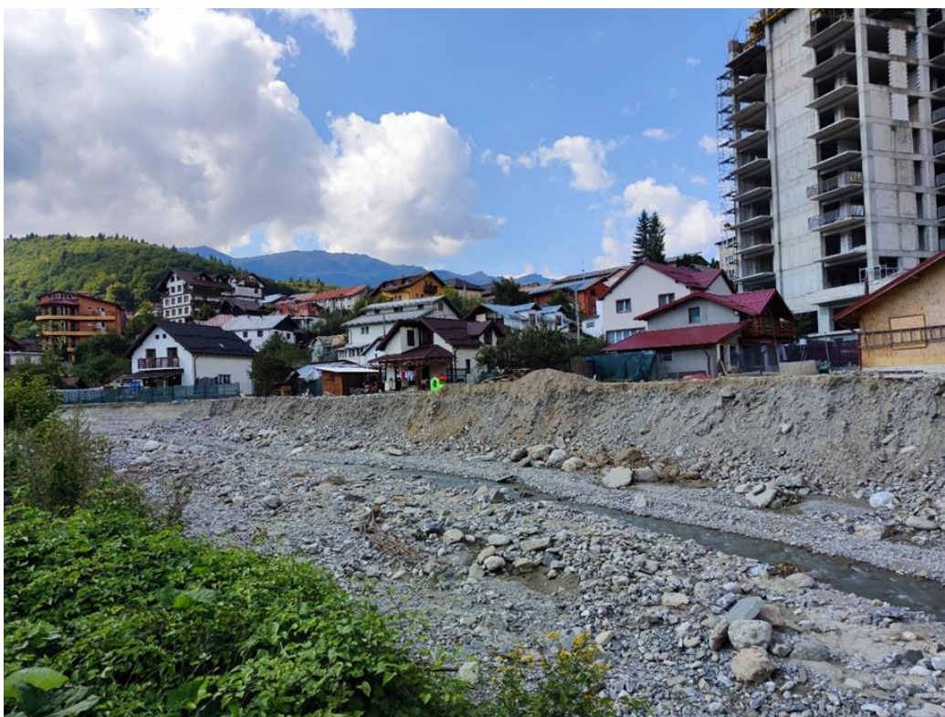
Figura 25. Aspectul solurilor erodate de pe Pârâul Dorului din Sinaia
